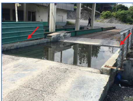
รูปที่ 2-15: ระบบฉัดล้างล้อรถบรรทุก
